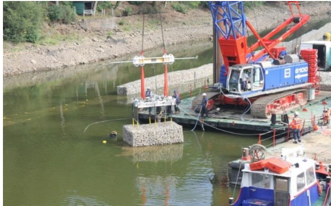
Figure 6 Mise en œuvre des gabions préremplis
